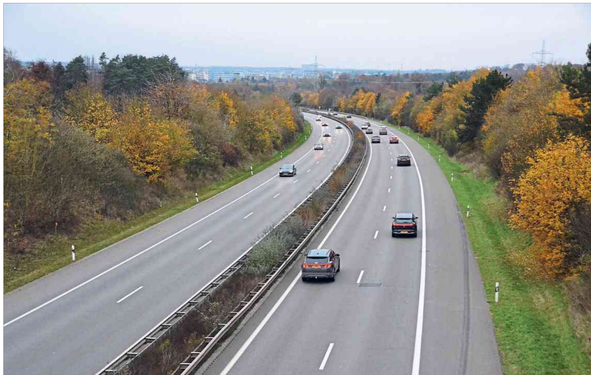
An dieser Stelle entsteht die neue Anschlussstelle. Foto: Frank Weyrich
